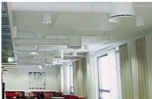
Pannello isolante omogeneo con superficie a vista in velo vetro bianco. Bordi smussati e rivestiti di colore bianco coprente su tutto il perimetro. Per solai di cantine, capannoni e garage sotterranei nonché per locali interni con particolari requisiti acustici.
