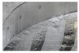
Pannello isolante compatto con rivestimento in alluminio su un lato per l'isolamento termico e acustico di condotte di aerazione.
