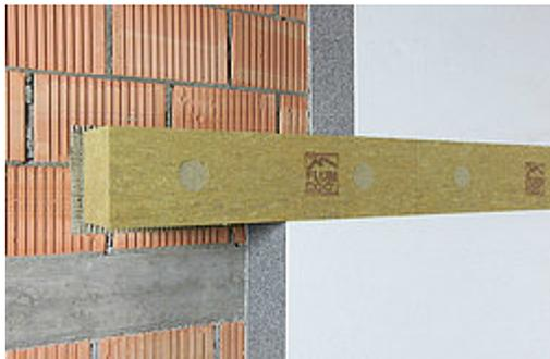
Traversa divisoria antincendio con orientamento speciale delle fibre per sistemi di isolamento termico esterni composti da strati singoli che comprendono materiali da costruzione combustibili.
