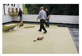
Pannello isolante resistente al calpestio per l'uso in tetti piani, previsti per essere utilizzati da persone e/o per installazioni. Come isolamento centrale nell'intercapedine di muri prefabbricati a doppia lastra in calcestruzzo.
