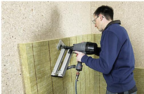
Pannello isolante a due strati con superficie specifica e ottima aderenza dell'intonaco per i vari sistemi isolanti termici esterni provvisti di intonaco nelle costruzioni in legno. Va agganciato su materiale in pannelli.
