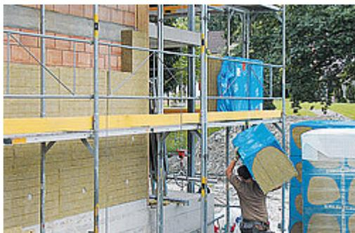
Pannello isolante a due strati con strato interno elastico e strato esterno più duro per coibentazioni sull'intera superficie di facciate ventilate, nonché per l'isolamento centrale nell'intercapedine di murature doppie a facciavista.
