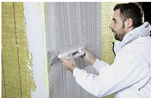
Pannello isolante a due strati con superficie specifica e buona aderenza dell'intonaco per i sistemi isolanti termici esterni provvisti di intonaco.
