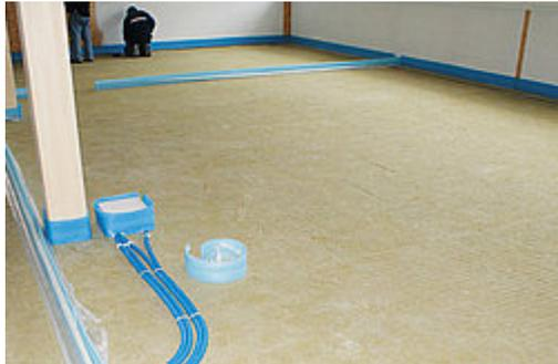
Pannello isolante omogeneo e resistente ad elevate sollecitazioni meccaniche sotto i betoncini flottanti. Come isolamento centrale nell'intercapedine di muri prefabbricati a doppia lastra in calcestruzzo.
