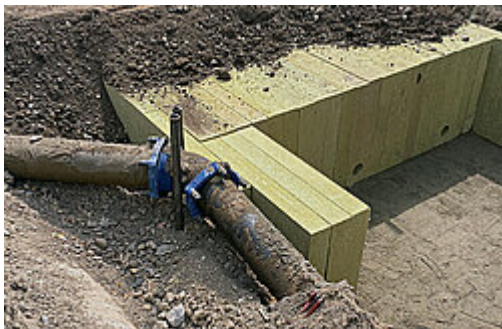
Elementi in Lana di Roccia per il rilascio delle acque piovane, anche a tempo prolungato.
