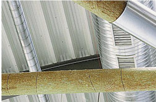
Coppella indeformabile e resistente alla compressione. Rivestimento antincendio di puntelli in acciaio e controventature a sezione tonda per una resistenza al fuoco di 30 – 120 minuti, rivestimento di condotte antincendio resistente fino a 90 minuti.
