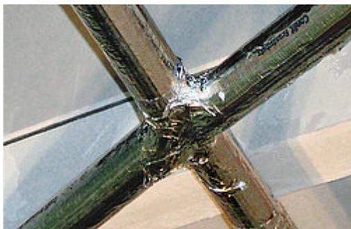
Coppella indeformabile e resistente alla compressione con rivestimento in alluminio. Rivestimento antincendio di puntelli in acciaio e controventature a sezione tonda per una resistenza al fuoco di 30 – 120 minuti, rivestimento di condotte antincendio resistente fino a 90 minuti.
