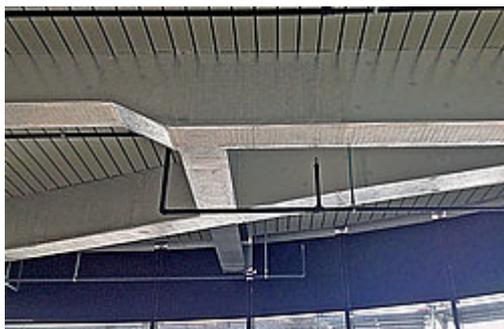
Pannello isolante indeformabile e resistente alla compressione con rivestimento in alluminio su un lato. Rivestimento antincendio di travi portanti e travetti in acciaio per una resistenza al fuoco di 30 – 180 minuti, rispettivamente di 30 – 120 minuti nel caso di puntelli in acciaio.
