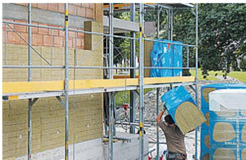
Panneau isolant bidensité avec couche intérieure élastique et couche extérieure plus dure pour l'isolation intégrale des façades ventilées ainsi que pour l'isolation intermédiaire des murs à double paroi avec briques de parement.
