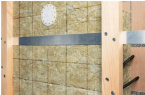
Panneau isolant bicouche avec couche intérieure élastique et couche extérieure plus dure avec rainures distantes de 200 mm. Isolation intégrale des façades ventilées pour systèmes de montage avec vis à distance et profilés en alu.
