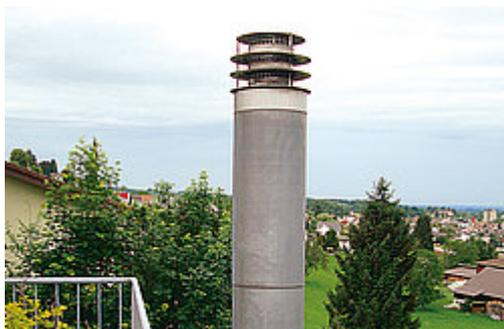
Alubeschichtete konzentrisch gewickelte und formstabile Rohrschale mit hohem Dämmwert bei geringer Dämmdicke. Als Wärmedämmung für Metallkamine entsprechend den Bestimmungen der VKF.
