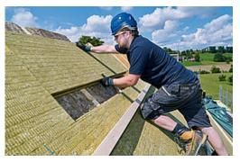
Druckfeste, grossformatige Dämmplatte, allseitig mit Nut und Kamm. Vollflächige Dämmschicht für Steildach- und Wandaufbauten.
