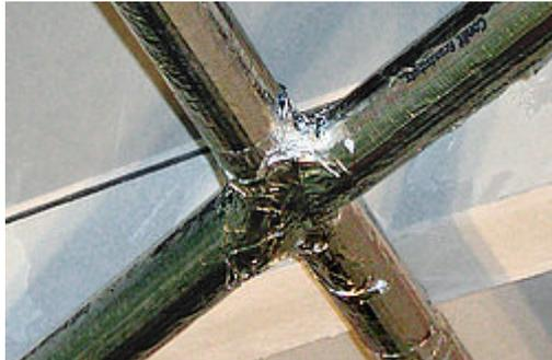
Druckfeste, formstabile Rohrschale mit Alubeschichtung. Brandschutzbekleidung von runden Stahlstützen und Windverbänden für die Feuerwiderstandsdauer von 30 – 120 min. Bekleidung von Feuerlöschleitungen bis 90 min.
