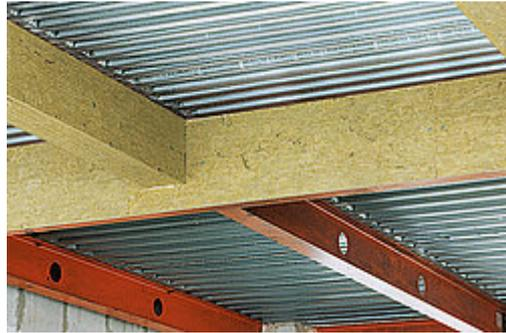
Druckfeste, formstabile Dämmplatte. Brandschutzbekleidung von Stahlunterzügen und Stahlträgern für die Feuerwiderstandsdauer von 30 – 180 min., resp. bei Stahlstützen von 30 – 120 min.
