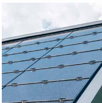
Ideale sotto impianti fotovoltaici
