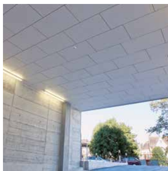
Exemple: entrée d'un garage souterrain.
