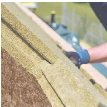
Verbindung mit Nut und Kamm
